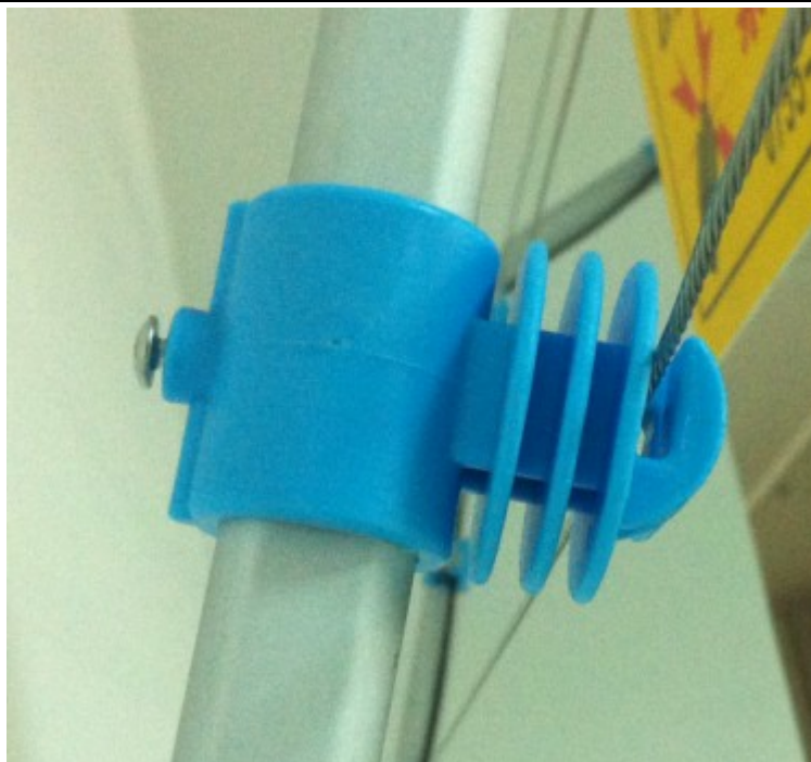
承力杆绝缘子安装方式
