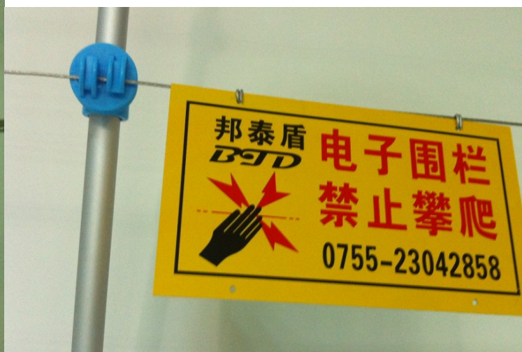
承力绝缘子挂合金线、警示牌的方式
