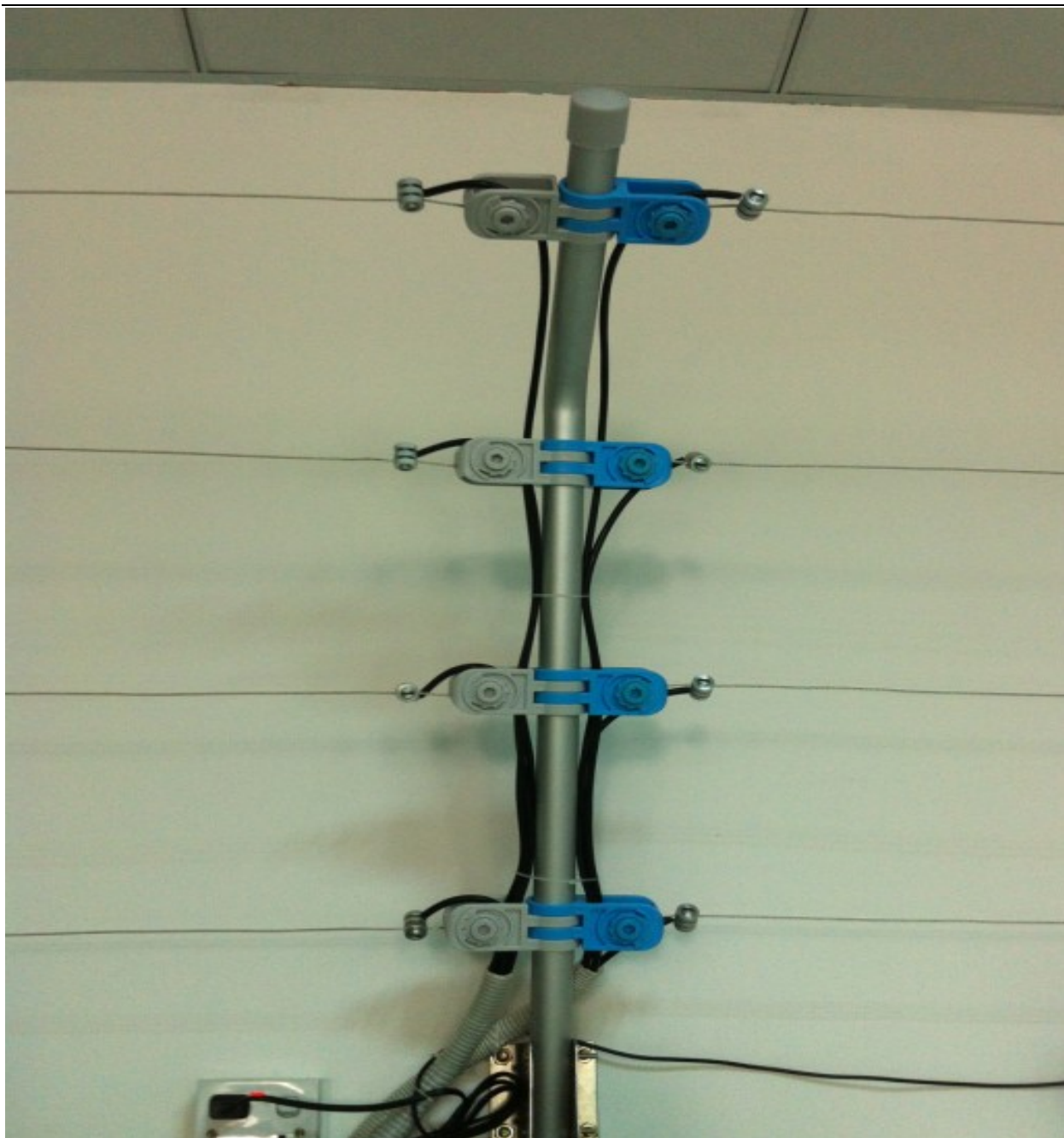
相邻两个防区共用一根终端杆的安装方式
